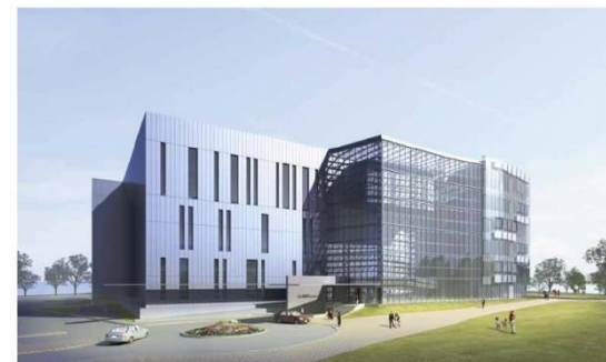
建屋(ポートアイランド)
